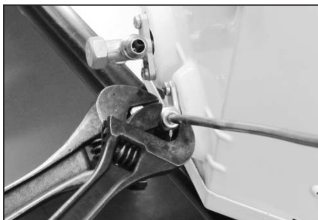
FIG. 24 - FIXAÇÃO DA PORCA
