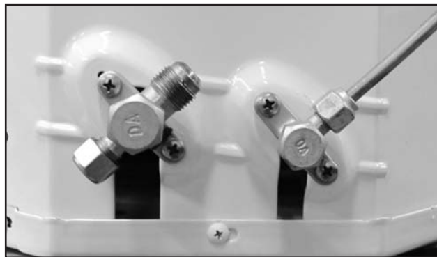
FIG. 25 - CONEXÃO DA LINHA DE LÍQUIDO DA UNIDADE CONDENSADORA
