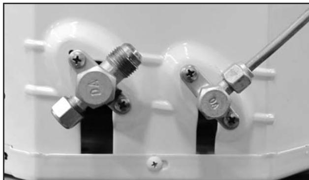
FIG. 57 - CONEXÃO DA LINHA DE EXPANSÃO DA UNIDADE CONDENSADORA
