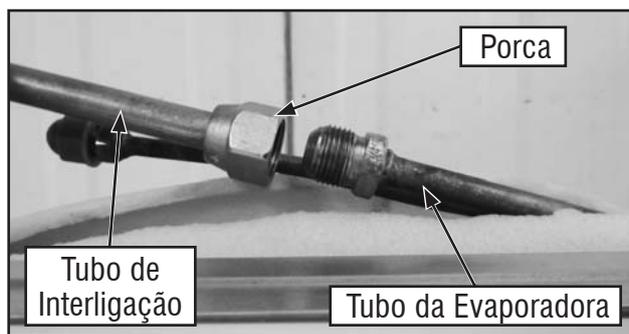
FIG. 27 - CONEXÃO DA LINHA DE SUCÇÃO
