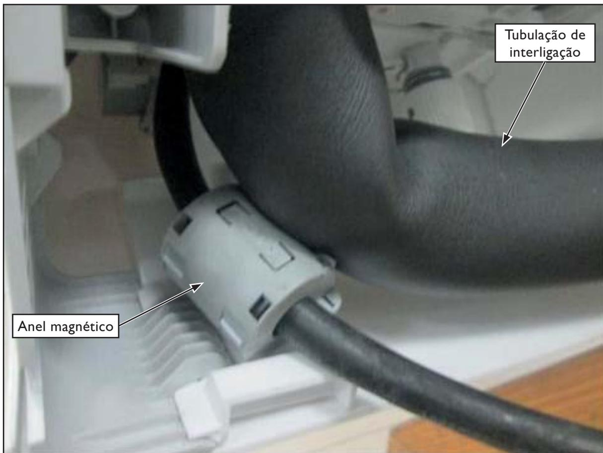
**Posição de instalação dos anéis magnéticos nas unidades condensadoras 38MB**
