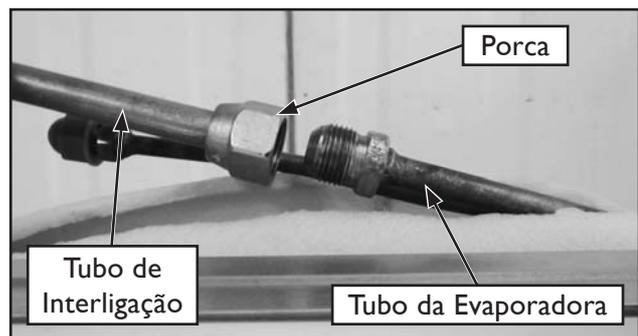
FIG. 26 - CONEXÃO DA LINHA DE SUCÇÃO
