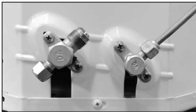
FIG. 32 - CONEXÃO DA LINHA DE EXPANSÃO DA UNIDADE CONDENSADORA
