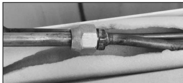
FIG. 33 - CONEXÃO DA LINHA DE SUCÇÃO DA UNIDADE EVAPORADORA
