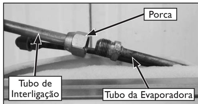
FIG. 32 - CONEXÃO DA LINHA DE SUCÇÃO
