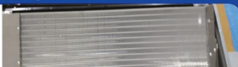
Cobre, sem proteção, sem dispositivo
