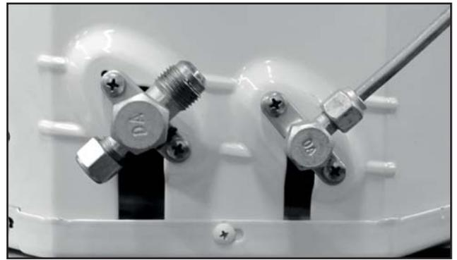
FIG. 46 - CONEXÃO DA LINHA DE EXPANSÃO DA UNIDADE CONDENSADORA
