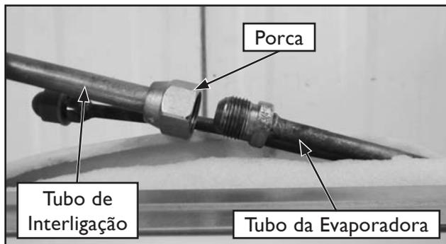
FIG. 58 - CONEXÃO DA LINHA DE SUCÇÃO
