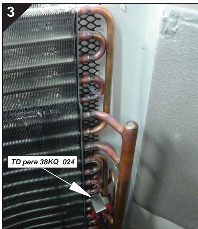
4. Faça a conexão elétrica do TD de acordo com os esquemas elétricos que acompanham o kit.
