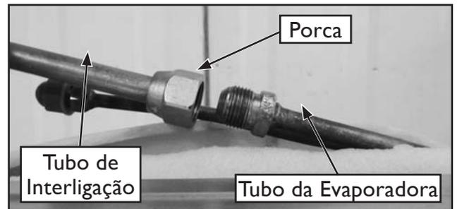
FIG. 40 - CONEXÃO DA LINHA DE SUCÇÃO
