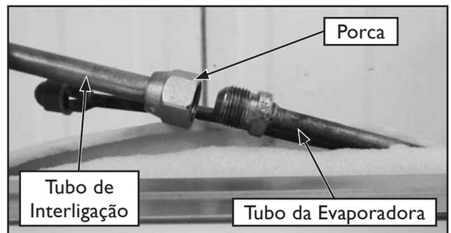
FIG. 33 - CONEXÃO DA LINHA DE SUÇÃO
